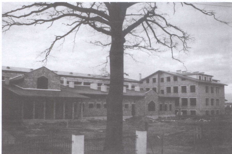
W budowie pełnowymiarowa hala sportowa w Borzęcinie
