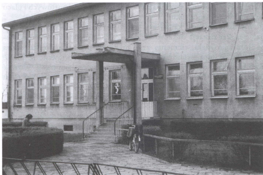
Budynek Ośrodka Zdrowia w Borzęcinie
