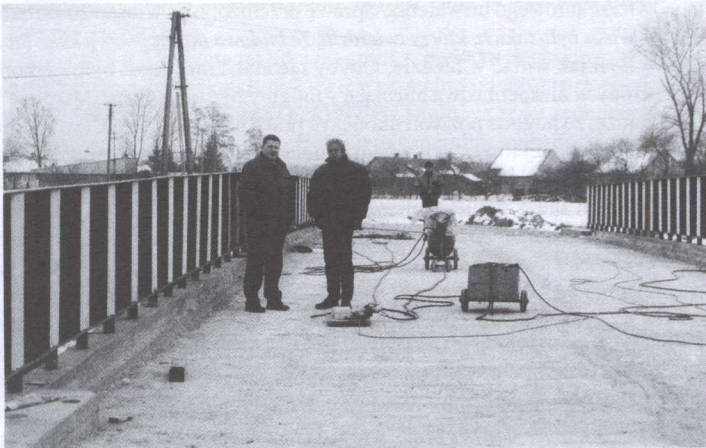
Nowy most już stoi. Wójt gminy wraz z kierownikiem budowy nie obawiają się o jego wytrzymałość - most wytrzyma nawet 20 ton.
