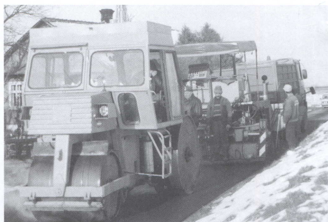
Na drodze „Przymiarki” ekipa drogowców kładzie nową nawierzchnię.
